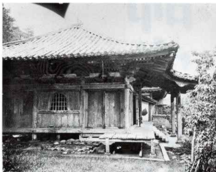
薬師堂 修理前
