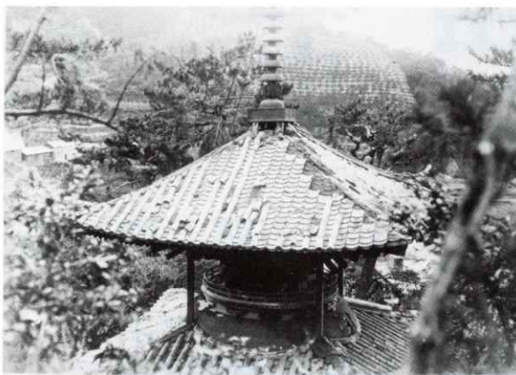
多宝塔 修理前
