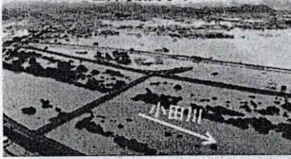
左岸側浸水状況
