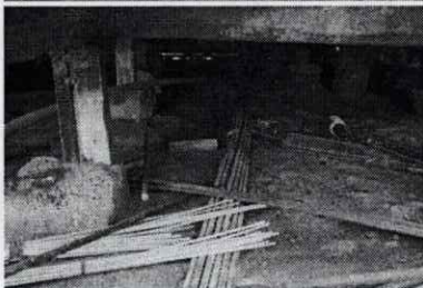
(上)高瀬地区の南さん宅で、毎年のように起こる洪水と水上げ小屋にまつわる話を聞かせてくれた住民の方々。左から山口裕久さん、芝 忠夫さん、芝 和恵さん、山口かよさん (下)南さんの母屋の床下。基礎をコンクリートで固めていないのは、浸水した水を土にしみ込ませるため
