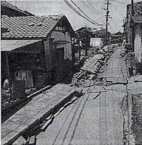
ブロック塀が倒れると、車椅子による避難や緊急自動車の通行に支障を来します。 （写真は熊本地震による被害）
