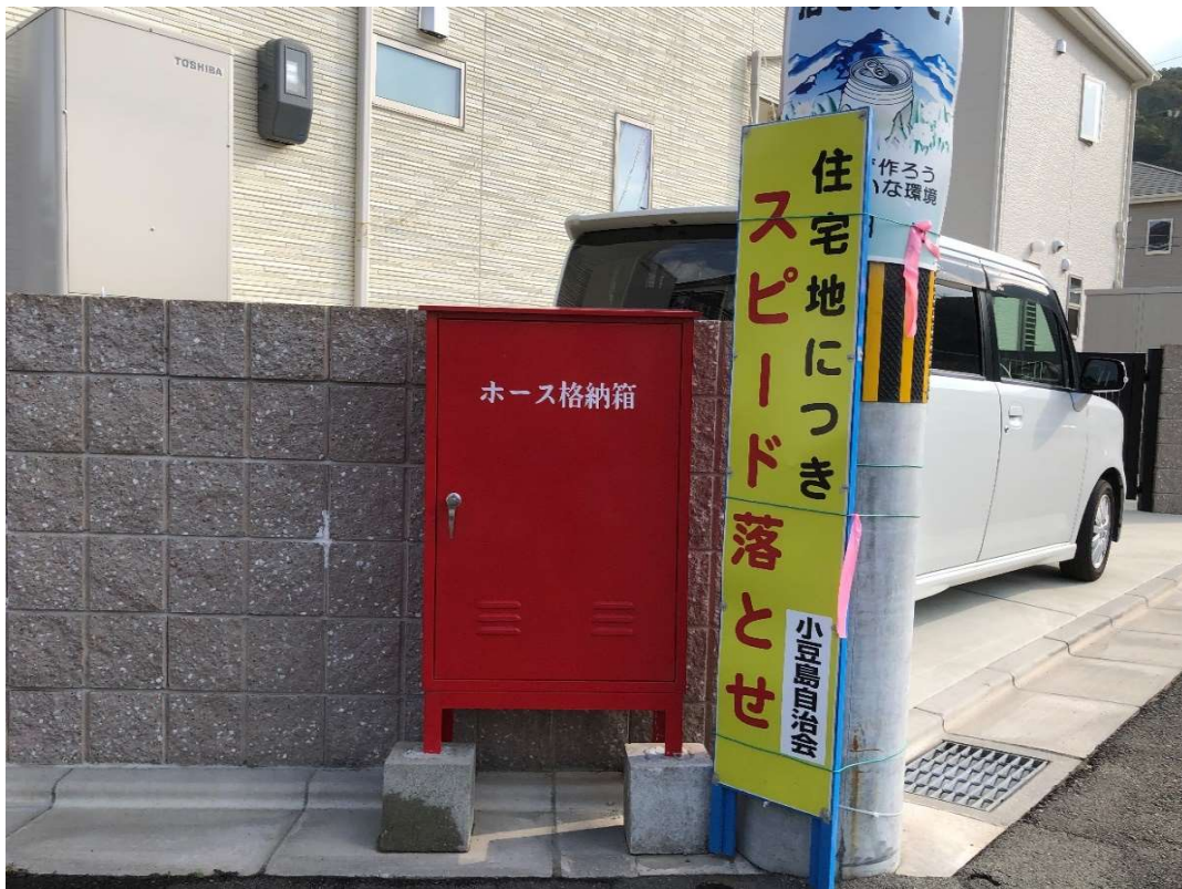
ホース格納庫 No.12：国尾 12月12日
