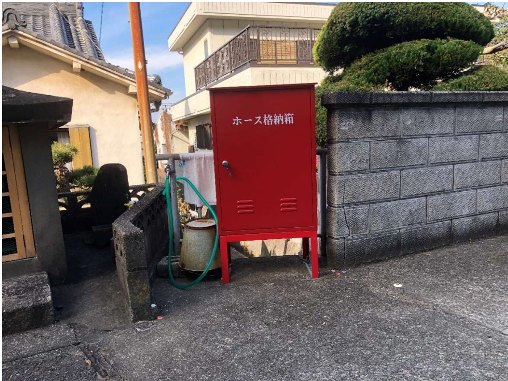
ホース格納庫 No.11：国尾 12月11日
