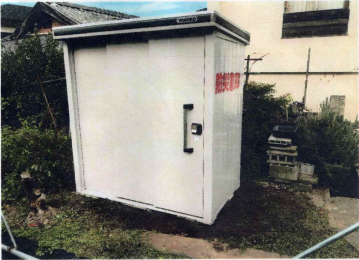
防災倉庫 設置（国尾：法正寺様敷地内） 20.10.21
