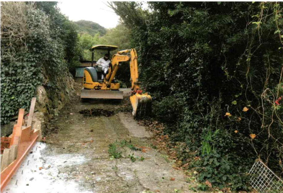
植樹撤去状況
