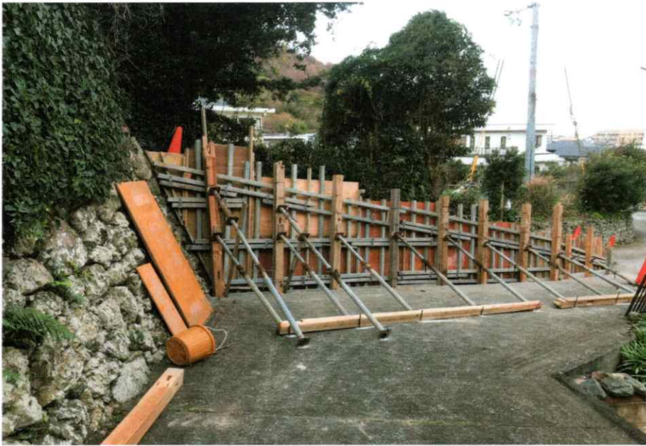
型枠組立完了
