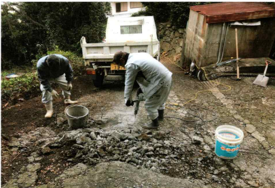
コンクリート研り状況
