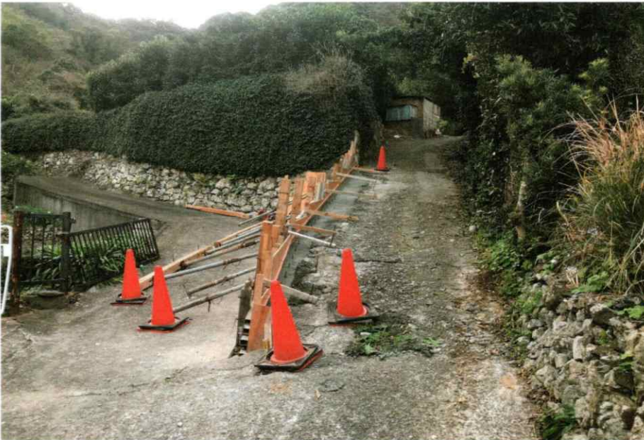
コンクリート打設完了
