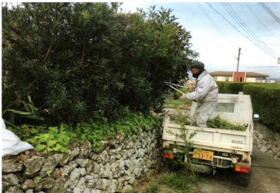
植樹撤去状況
