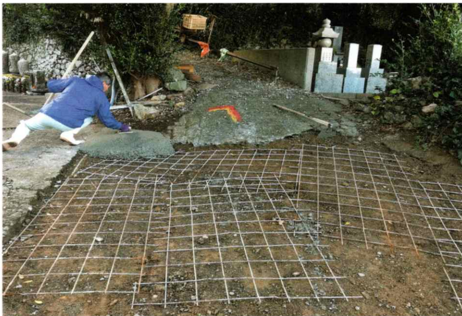
コンクリート打設状況
