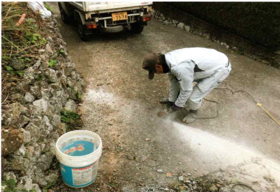
コンクリート切断状況
