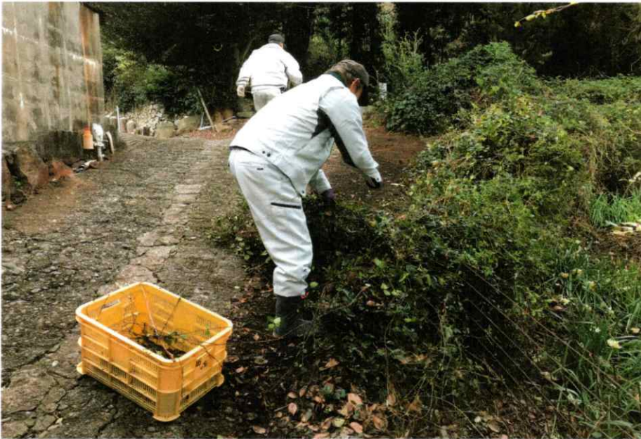
植樹撤去状況
