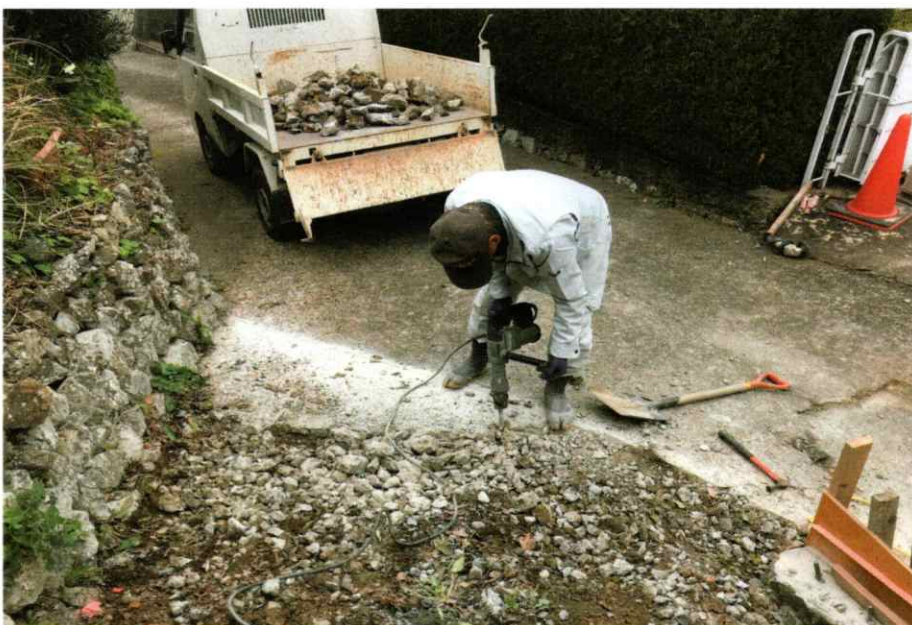
コンクリート研り状況
