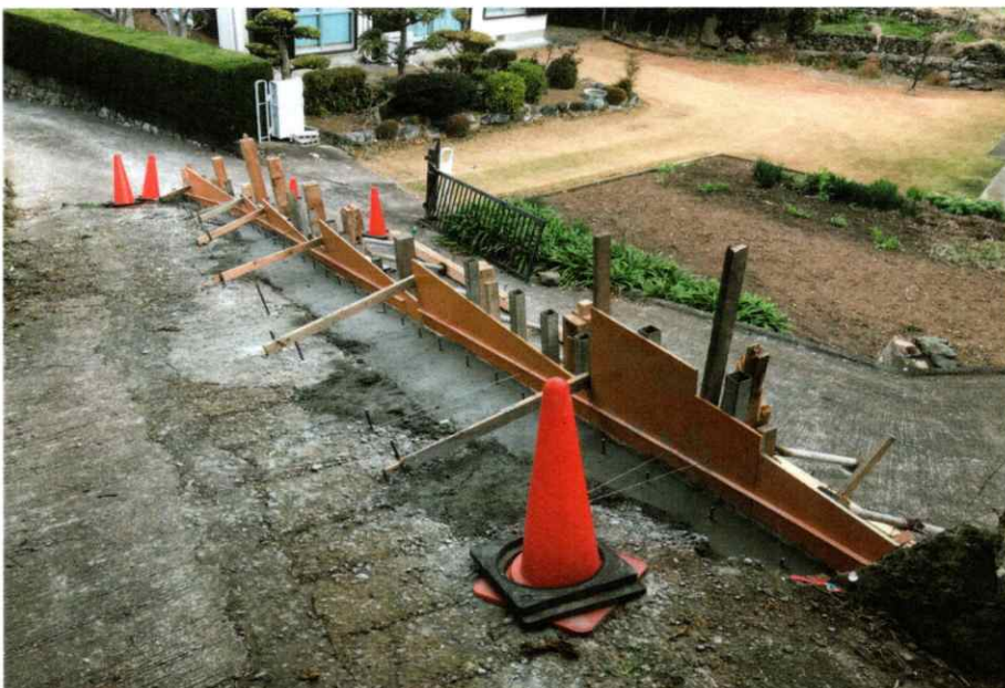
コンクリート打設完了
