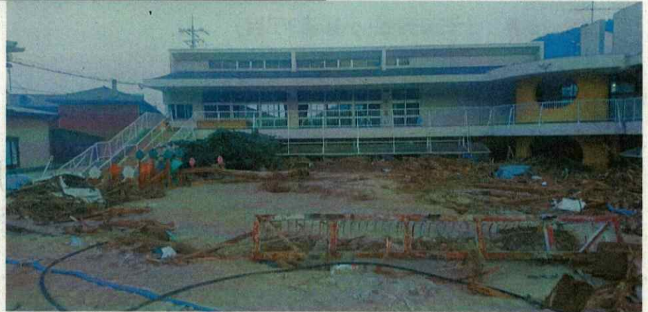
▶ 土砂や流木が流入 (小屋浦みみょう保育園)
