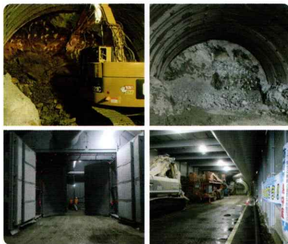
5号トンネル掘削の様子
