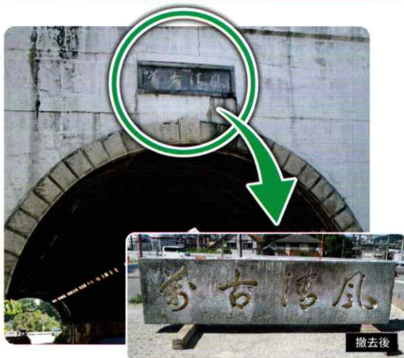
藤白トンネルに設置されていた銘板
