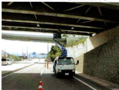
高所作業車作業状況（例）
