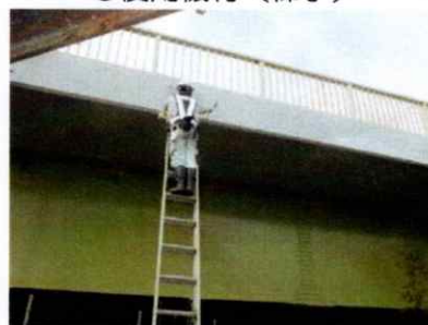
梯子による作業状況（例）
