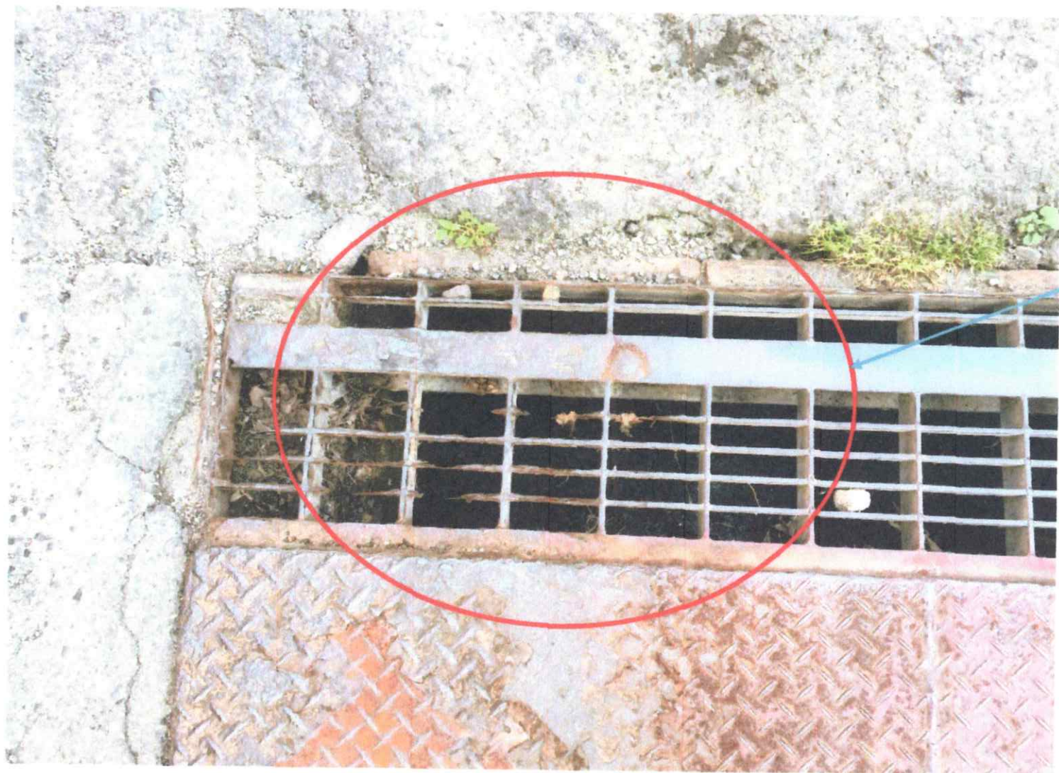
写真2 錆が進み、朽ちてきている部位
