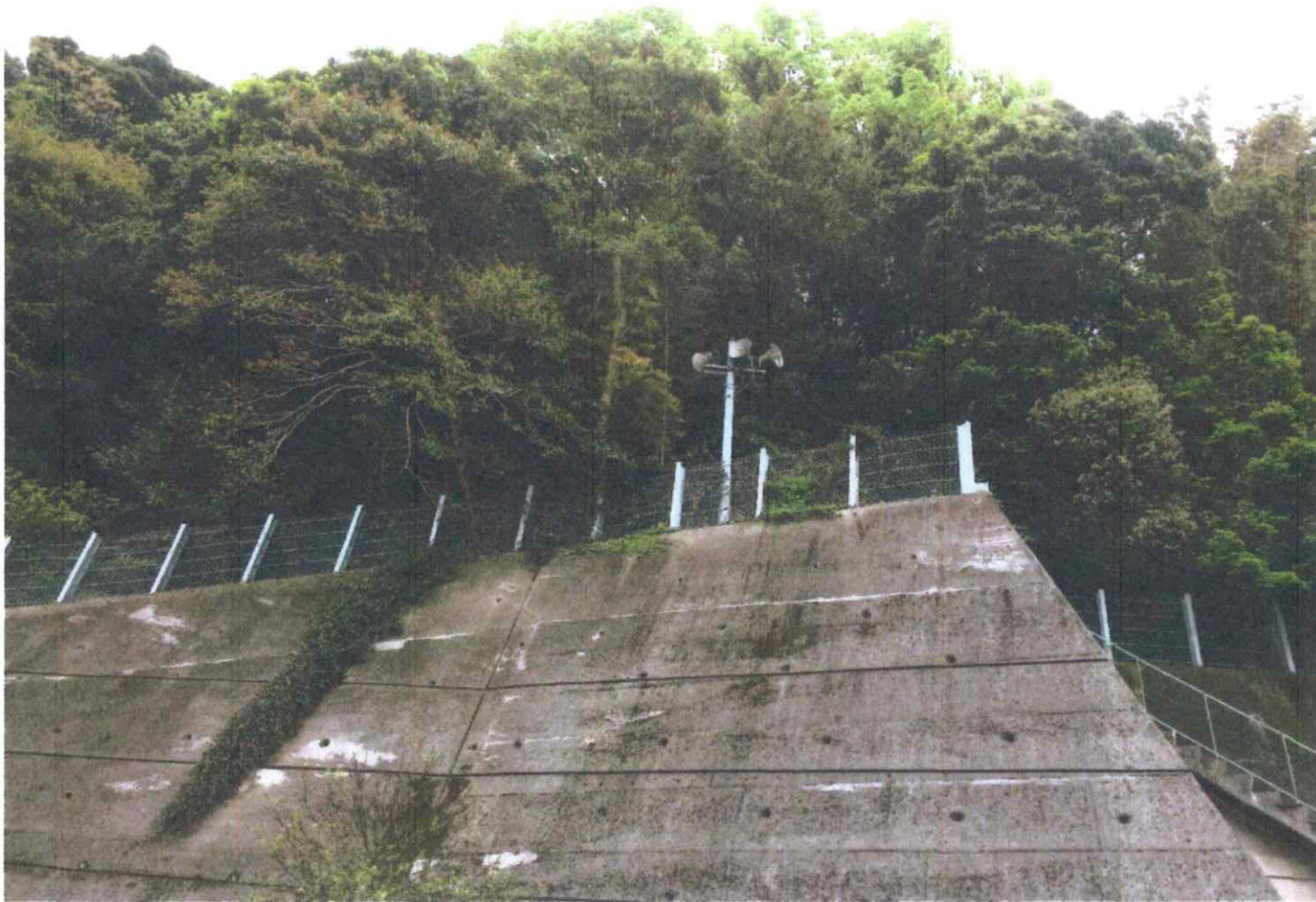
写真1 スピーカー取り付け全体写真
